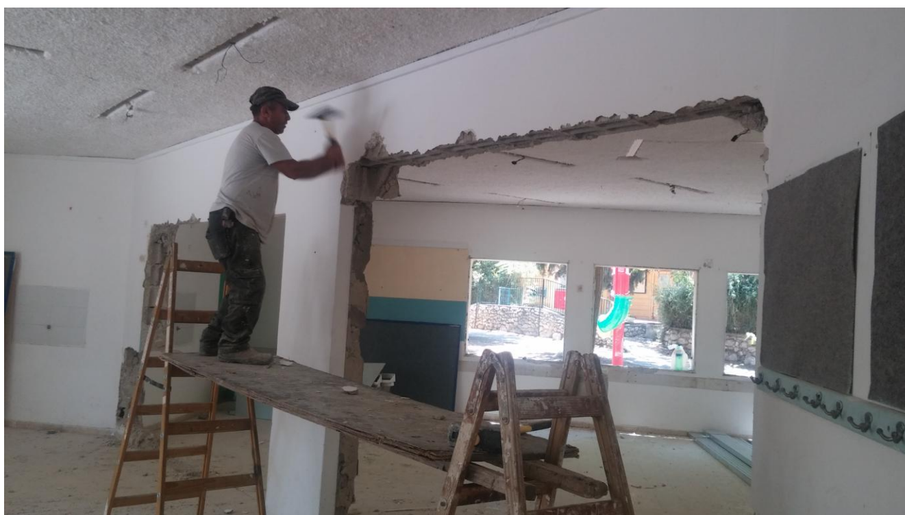
Renoveringen av skolbiblioteket
