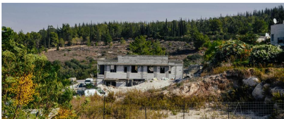
Ett av de nya husen tar form!
