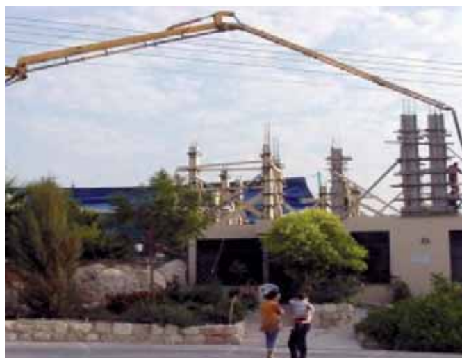
Ein neues Haus entsteht
